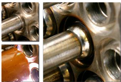
元件轨道焊接进行管板连接
